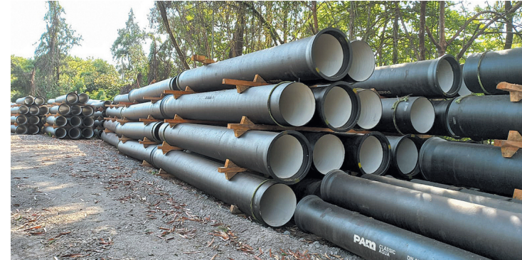
Tubos que chegaram para obra na Beira-Rio já estão armazenados
